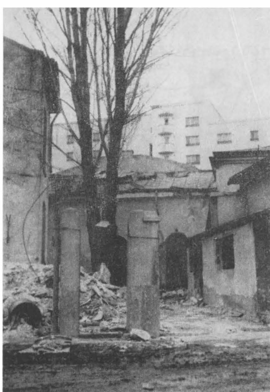
«Casa Cilibiului» (Florescu) — vedere dinspre str. Vinători. Acum această parte a casei este cea mai distrusă.
