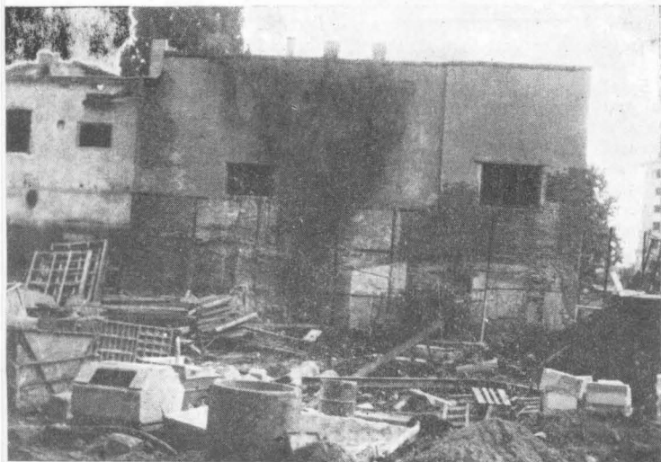
Clădire ce a adăpostit ateliere ale « Institutului Biblic și de Misiune Ortodoxă » — orientare vest — nord-vest.
