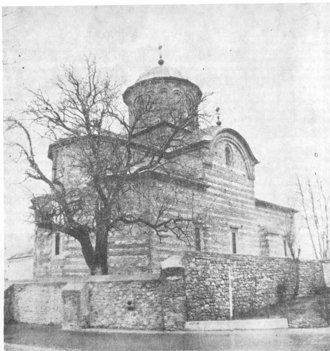
Biserica Domnească din Curtea de Argeș, monument la care ni se semnalează unele degradări pricinuite de cutremurul din 1838.
