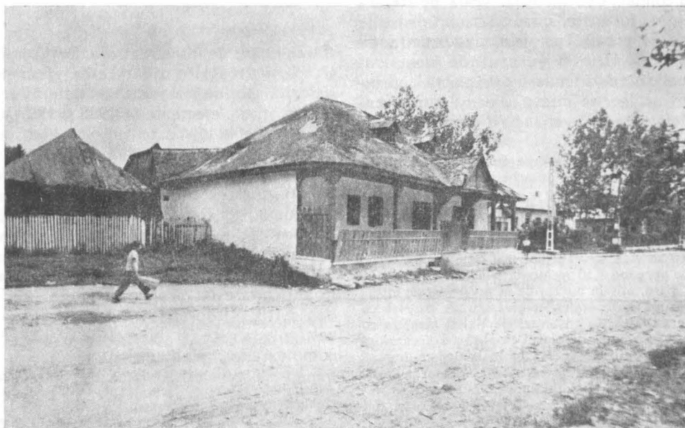
Fațada principală și foișorul de pe latura sudică — Hanul din Chiojdu, județul Buzău
