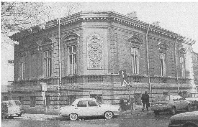
Fig. 1. Fațada reprezentativă a Locuința din str. Nuferilor nr. 52 (foto: Ion Popa - Arhiva)
