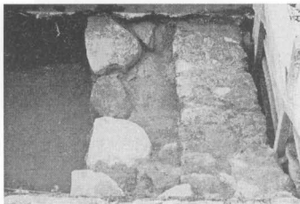
14. Caseta C V – zid aparținător construcției vechi din dreapta intrării în castel
