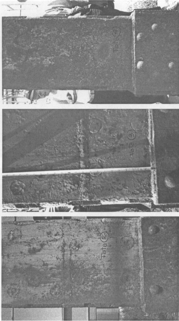
Imagina gradului diferit de ruginită a trei dintre fețele stălpului (fețele 2, 3 și 4)
