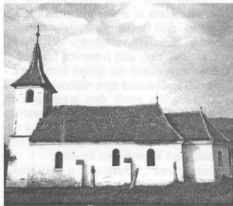
Fațada sud (foto nr. 3)
