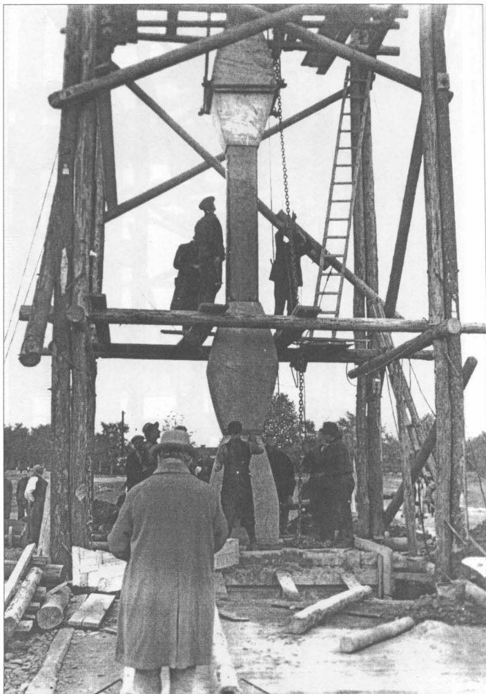
Foto 15. Tragerea pe stâlp al celui de-al doilea modul (Brâncuși cu spatele)
