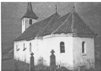
Fațada dinspre sud-est (foto nr. 4)
