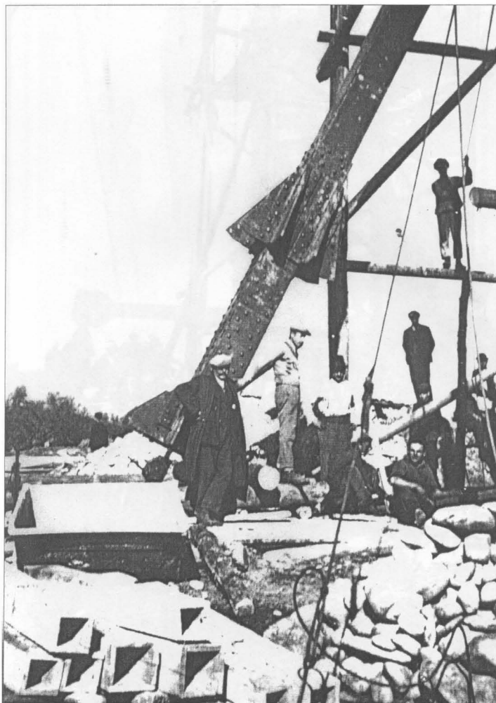
Foto 6. Ridicarea structurii de rezistență
