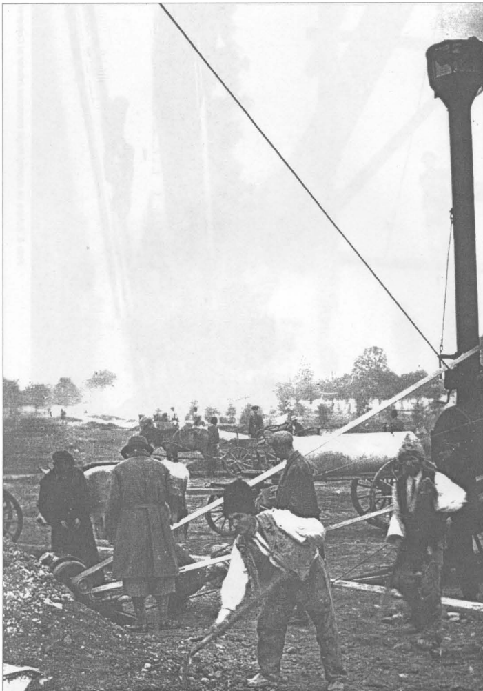
Foto 4. Organizarea șantierului de montaj al Coloanei la Târgu-Jiu
