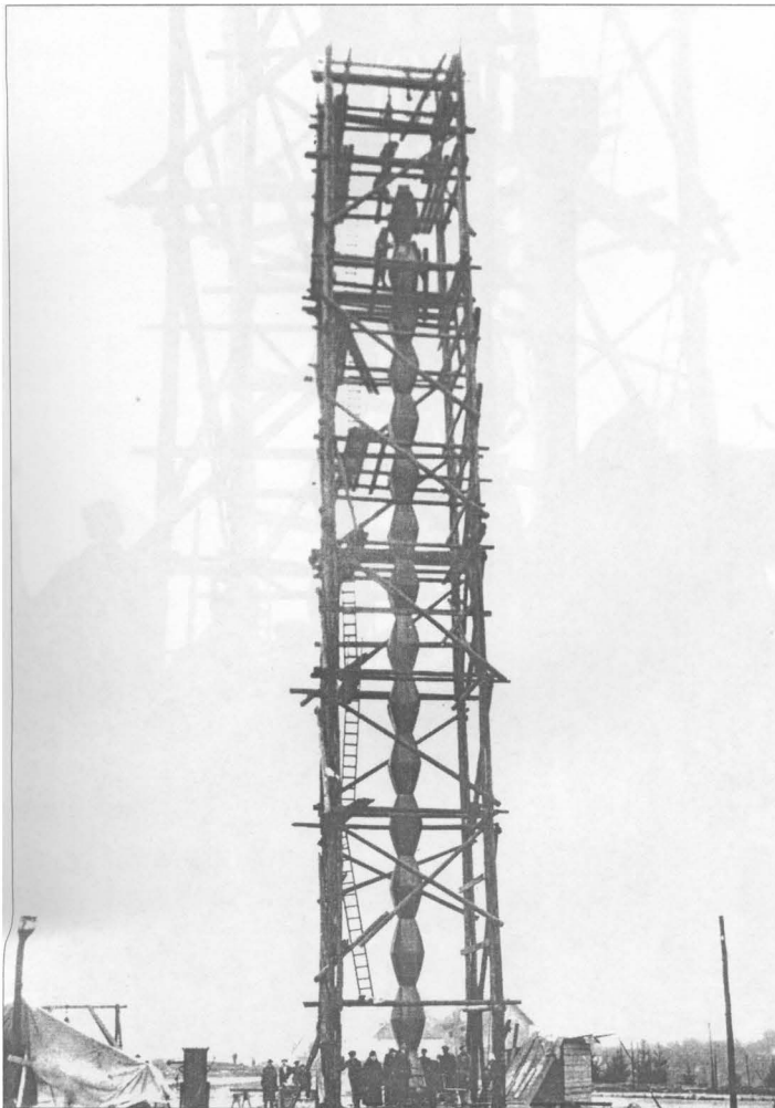
Foto 24. Toate cele 15 elemente sunt trase pe stâlp
