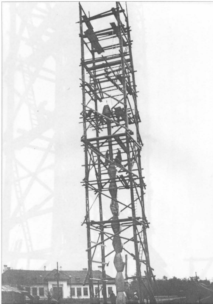
Foto 18. Tragerea pe stâlp al celui de-al 8-lea element
