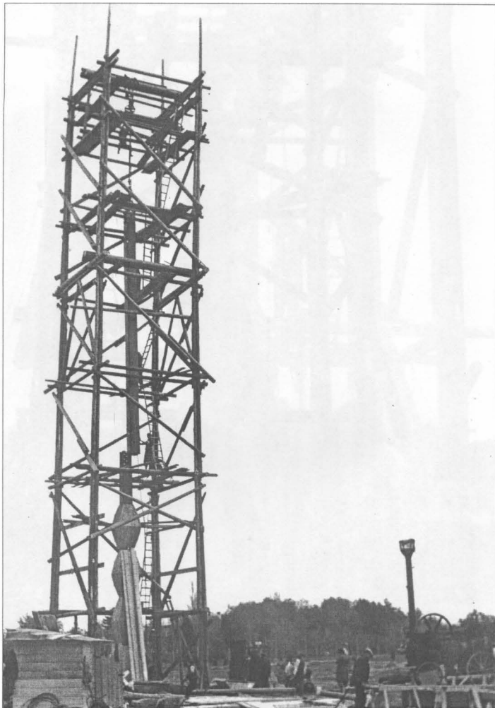
Foto 17. Tronsonul II de stâlp în poziție aproape verticală
