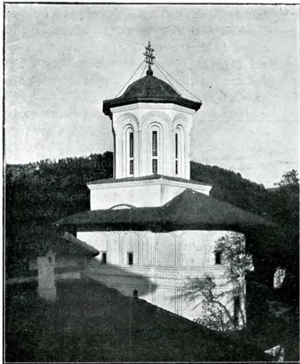
37. Paraclisul mănăstirii Hurezi. — Vedere exterioară, dela răsărit. — — După restaurare. —
