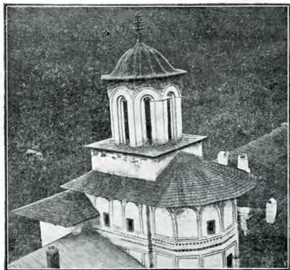
38. Paraclisul mănăstirii Hurezi. — Vedere exterioară, dela răsărit. — — Înainte de restaurare. —
