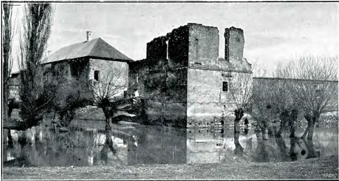
51. Ruinele castelului domnese din Vințul-de-jos
