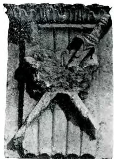
Consolă sub bolți. — Două spade încrucișate într'o coroană. —
