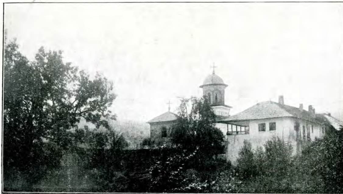
1. Vedere generală, spre intrare.
