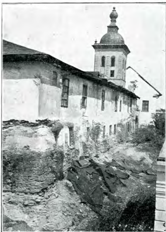
9. Aceiași fațadă din spre str. Milhăi Vodă, după tăierea salcânilor, în 1912.
