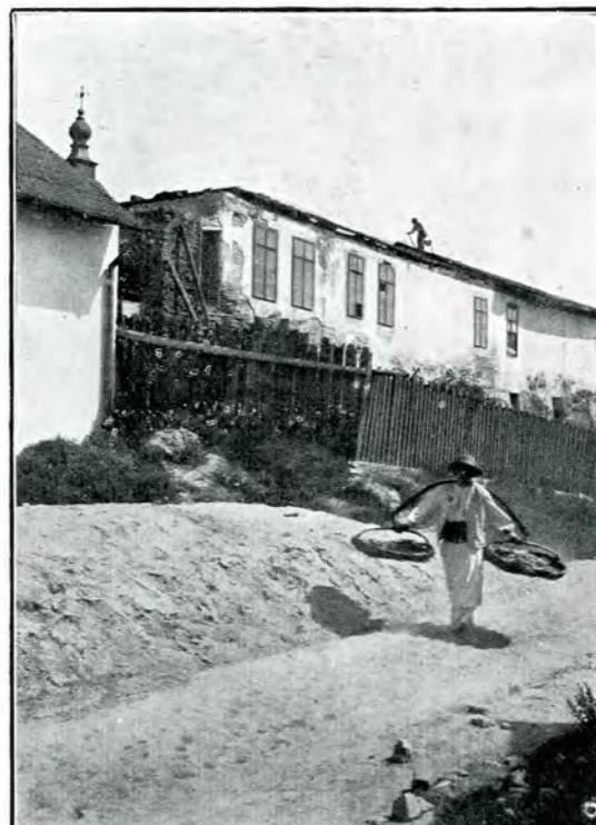
12. Fațada din străduța Arhivelor, în timpul dărâmării (1912).
