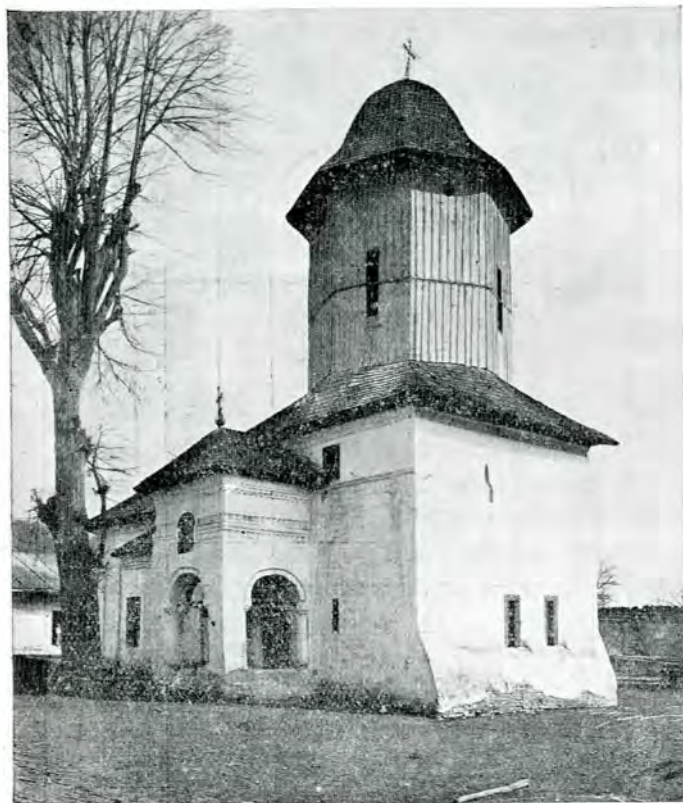
Fig. 4. — Vedere înainte de restaurare.
