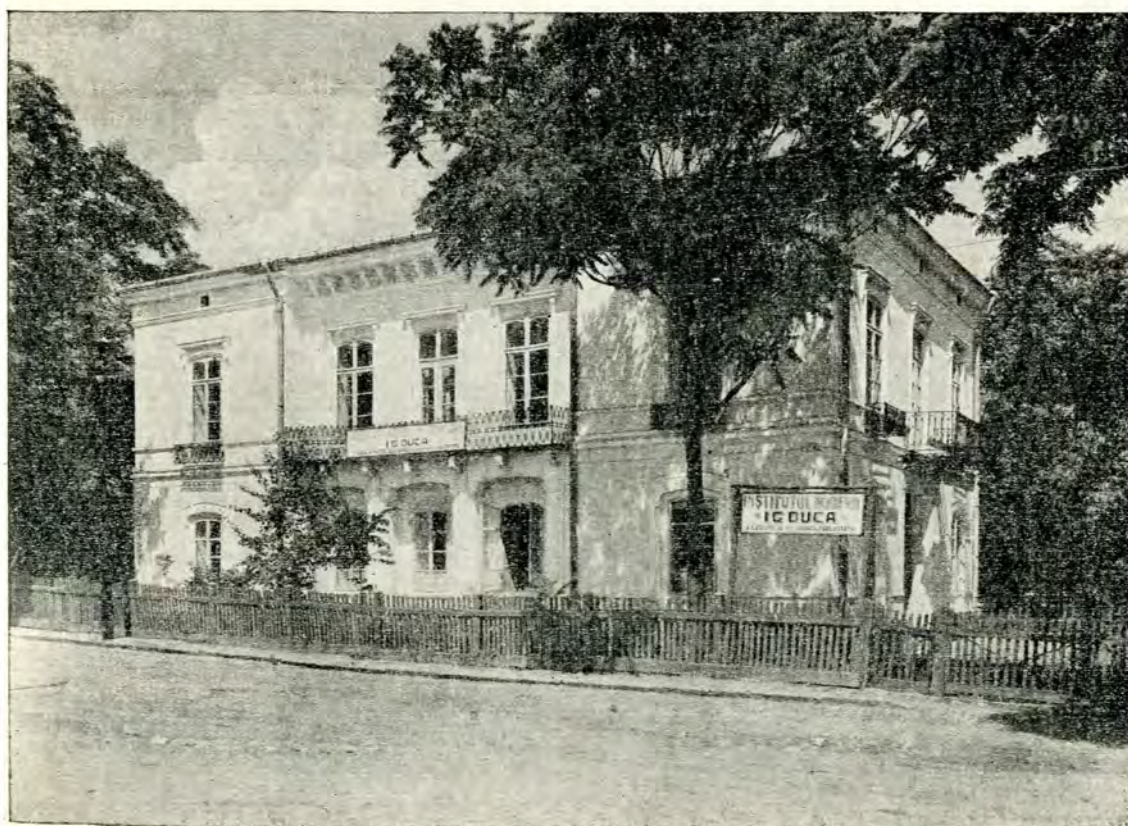
Fig 30. – Aceiași, altă vedere.
