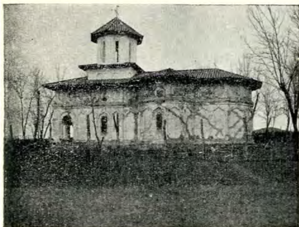
Fig. 30. - Biserica Săftica, după restaurarea acoperișului.
