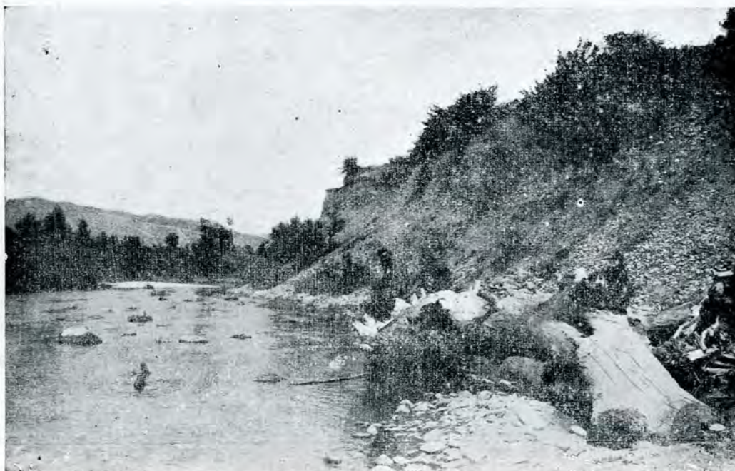
Fig. 9. – Castrul Bumbesti, vedere spre râpa Jiului. La rîpa della Jiul colla distruzione del castrò.
