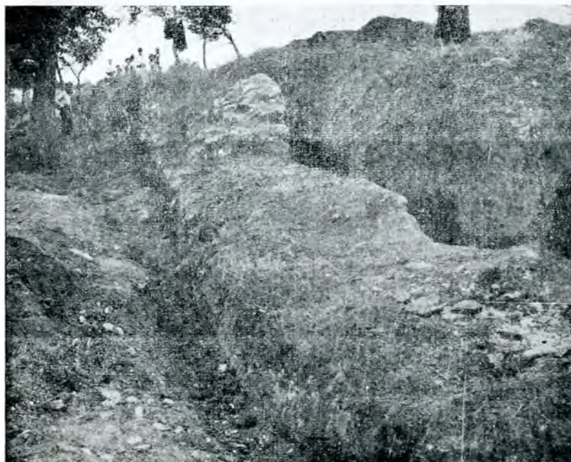
Fig. 5. — Zidul castrului. II murs del castro.
