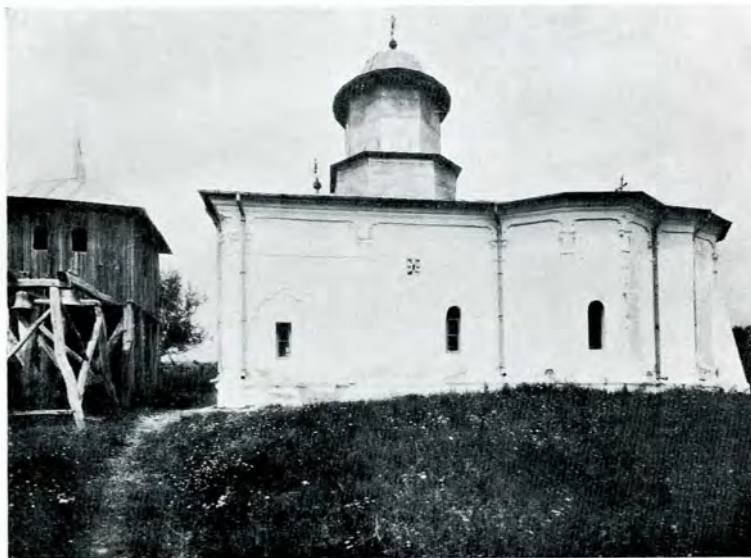
Fig. 1. — Biserica din Vadu-Săpat. Vedere din spre Sud.
