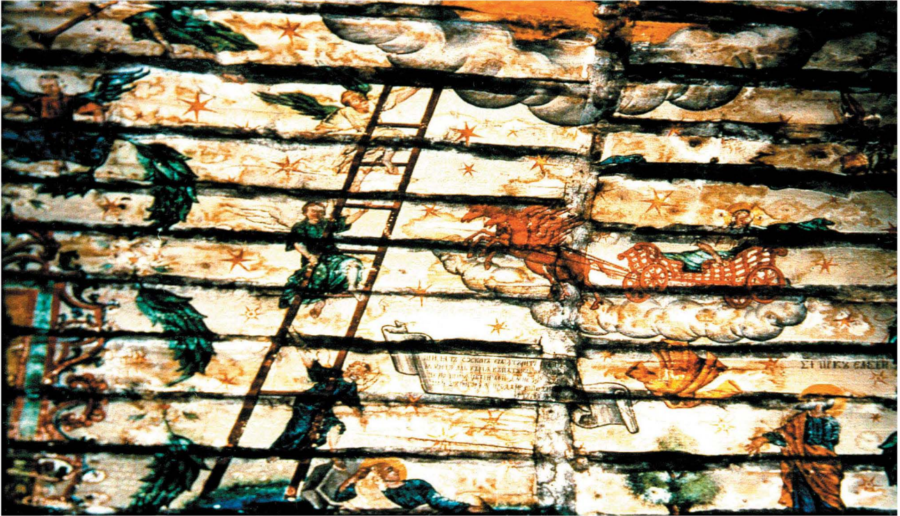
Șurdești. Nef, voûte Șurdești. Nave, vault
