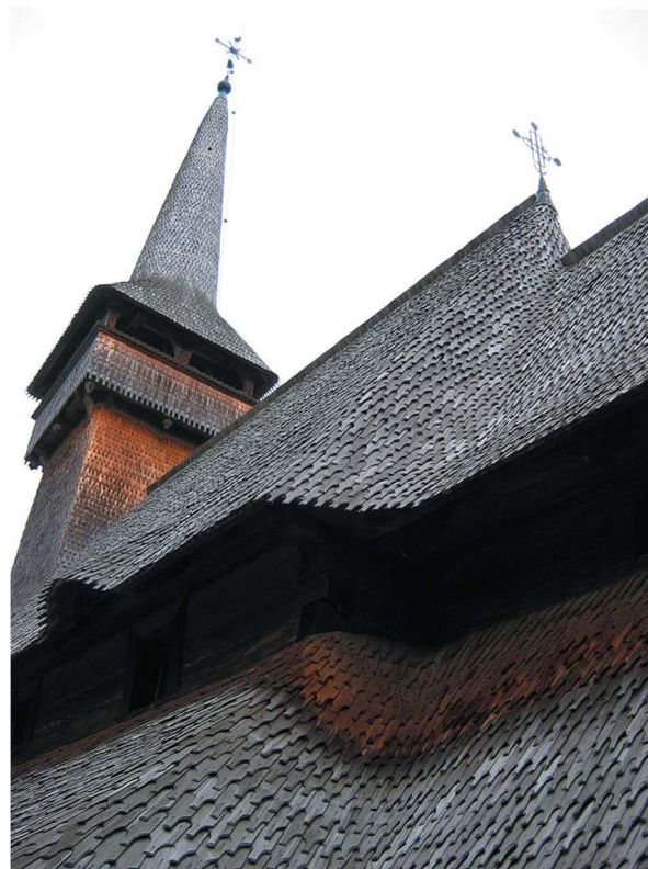
Poienile Izei, la toiture Poienile Izei, the roof
