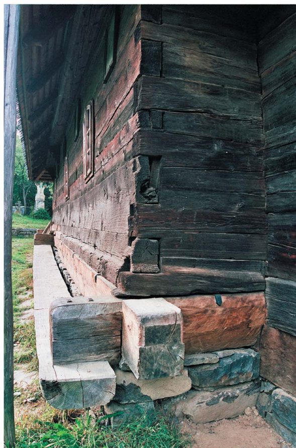
Budești. "Blockbau" construction Budești. "Blockbau" system
