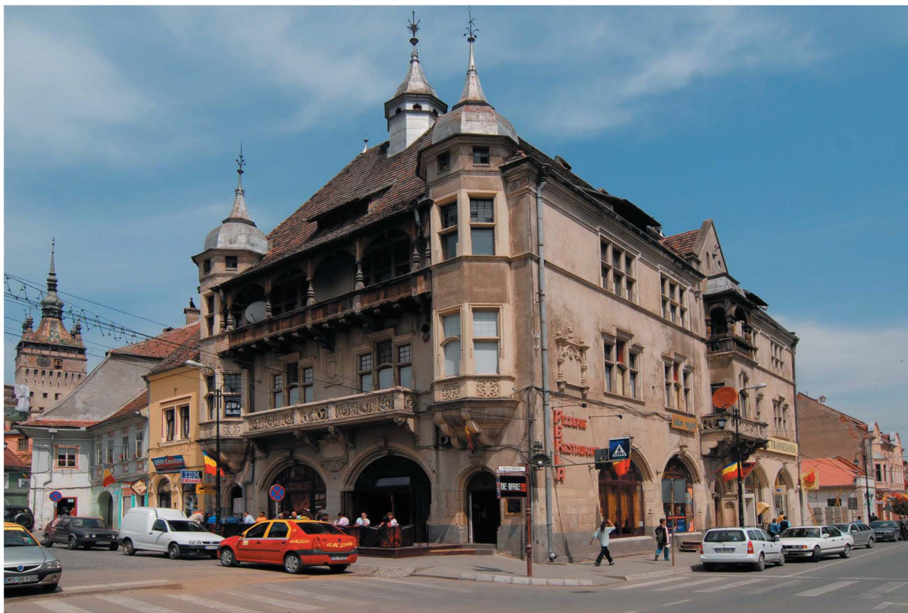
La Ville Basse, Place Hermann Oberth, immeuble Gewerbevereinshaus The Lower Town, Hermann Oberth Square, Gewerbevereinshaus Building
