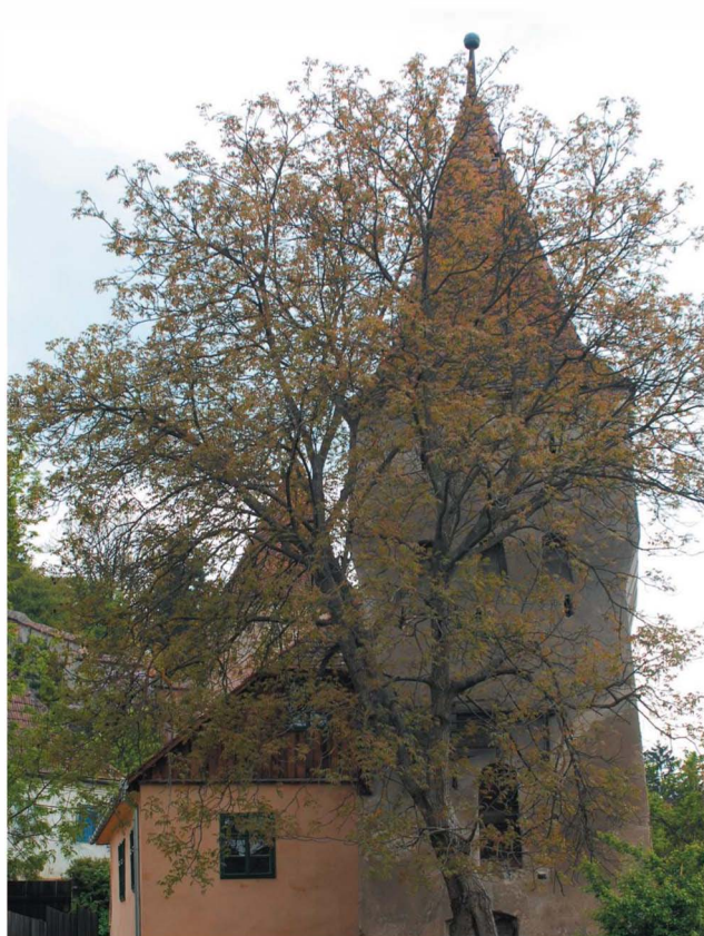
La Tour des Pelletiers The Furriers' Tower
