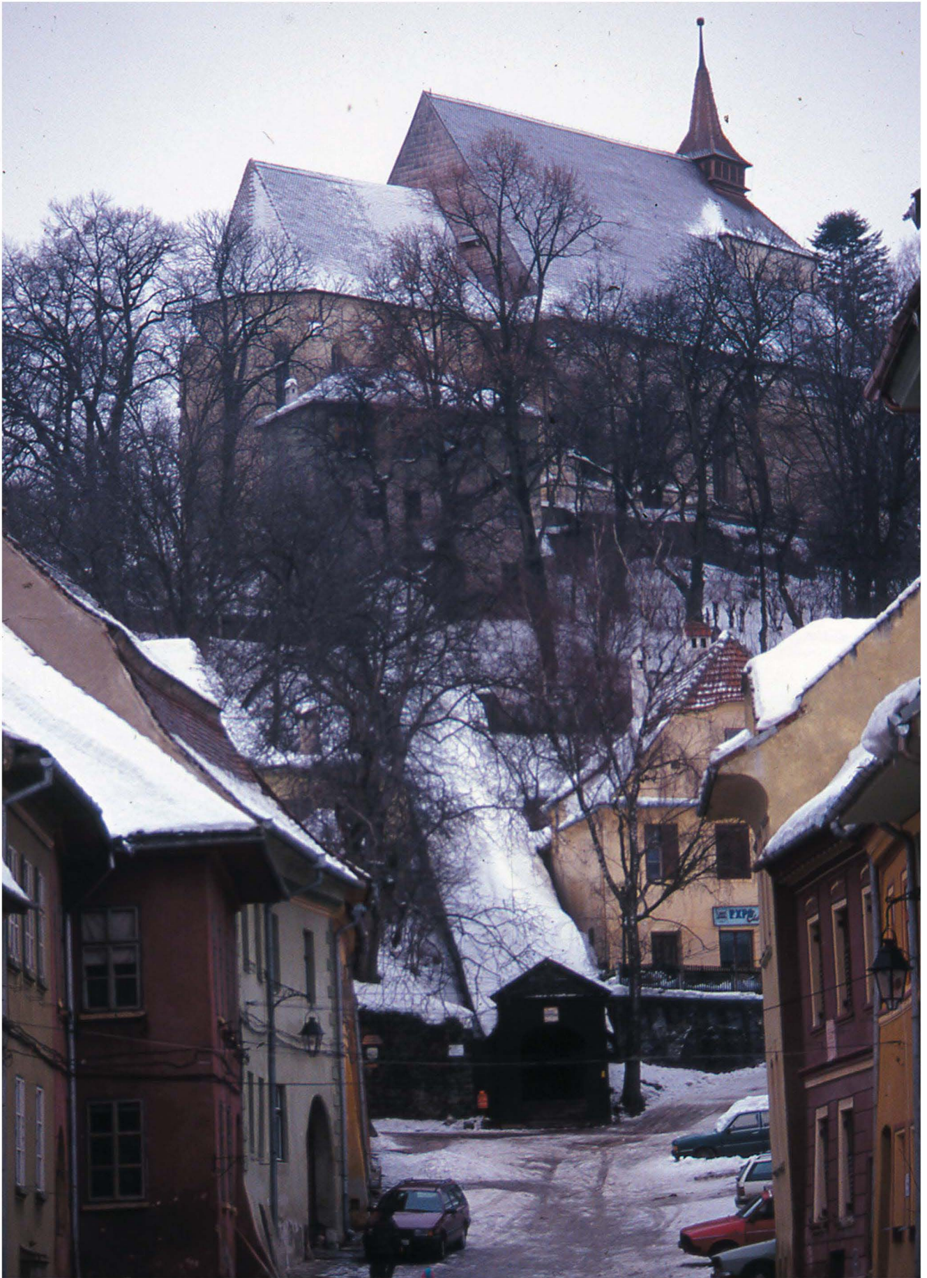
L'escalier en bois couvert et l'Eglise de la Colline Wooden staircase and the Church of the Hill
