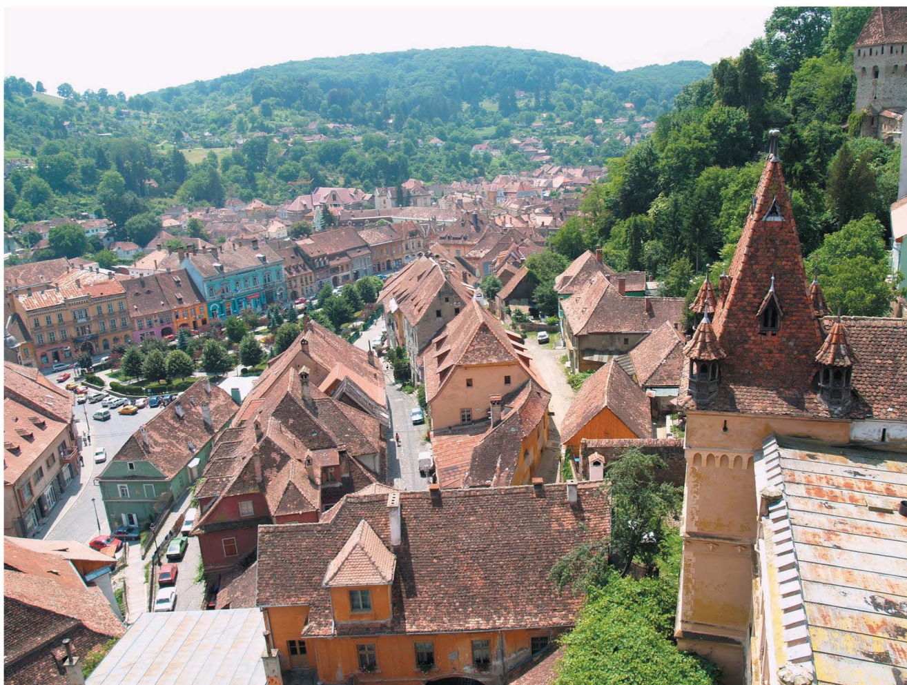
La Ville Basse, vue générale Lower Town, overall view
