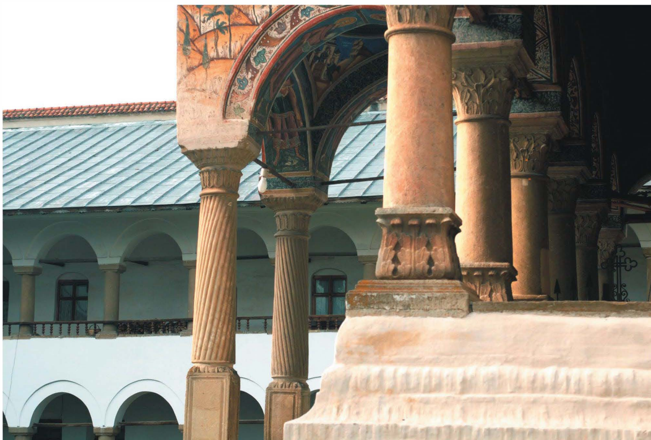
La Grande Eglise, les colonnes du porche Great Church, porch columns
