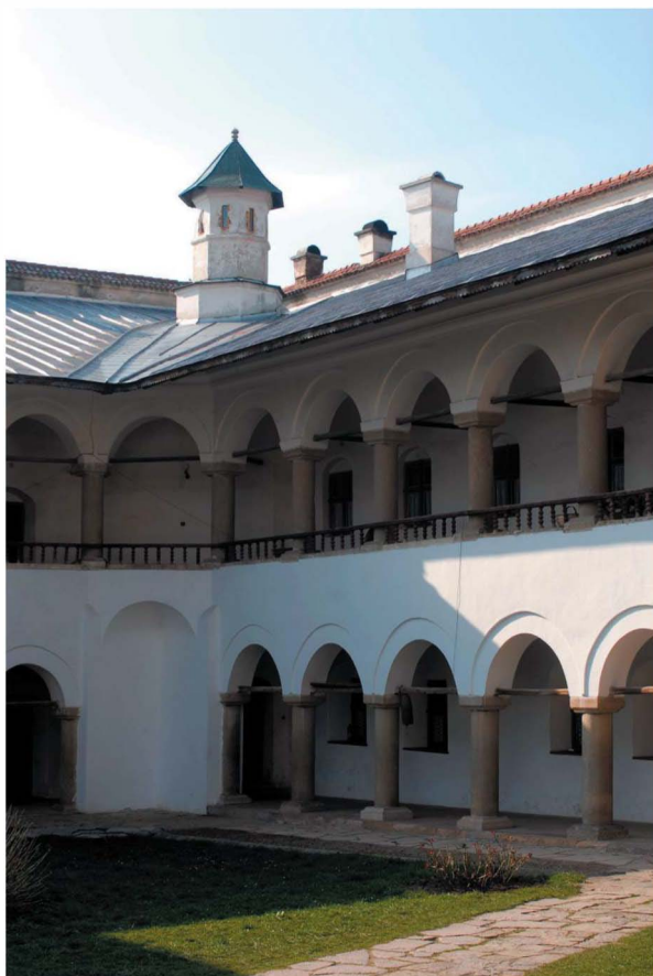
Vue de la cheminée, extérieur de la cuisine Kitchen chimney
