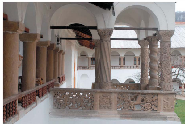
Vue du Belvédère de Dionisie View, Dionisie's high porch
