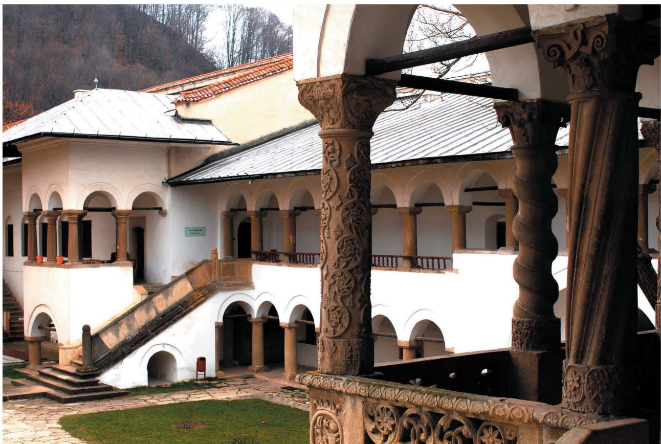
Vue de la grande enceinte prise du Belvédère de Dionisie, côté sud Larger compound southern side, view from Dionisie's high porch
