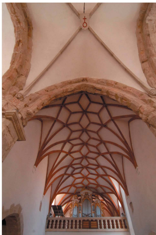
Voûtes du bras ouest de l'église Vaults of the church west arm
