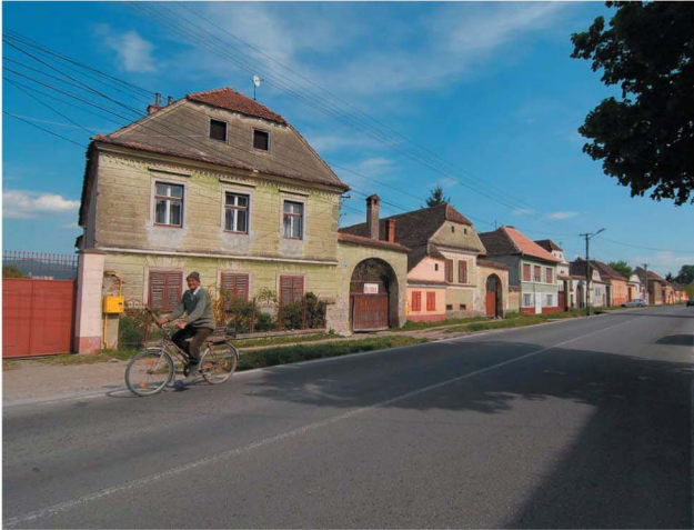
Front de la rue Brașovului House fronts on Brașovului street
