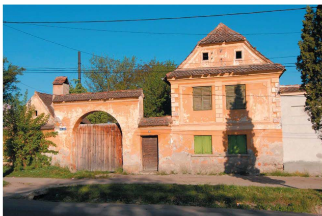
Maison n°566, rue Mare House no. 566 on the main street
