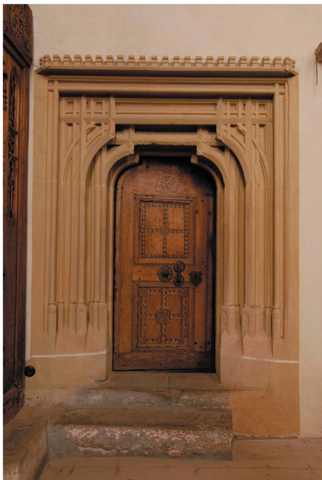
Encadrement de la porte de la sacristie Sacristy door frame
