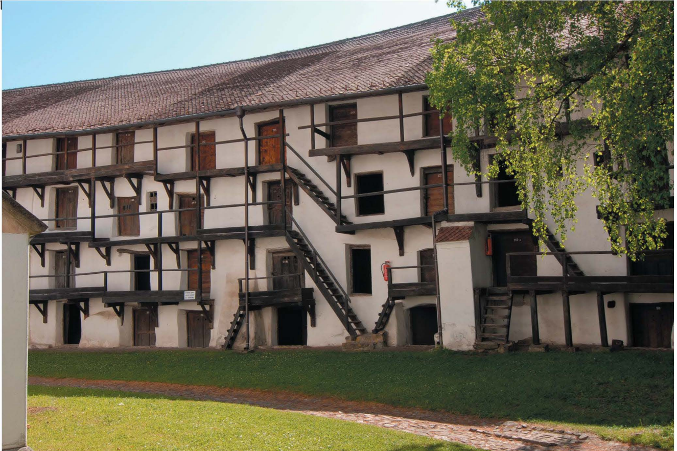
Pièces destinées au stockage des vivres dans l'enceinte principale Main precinct storerooms
