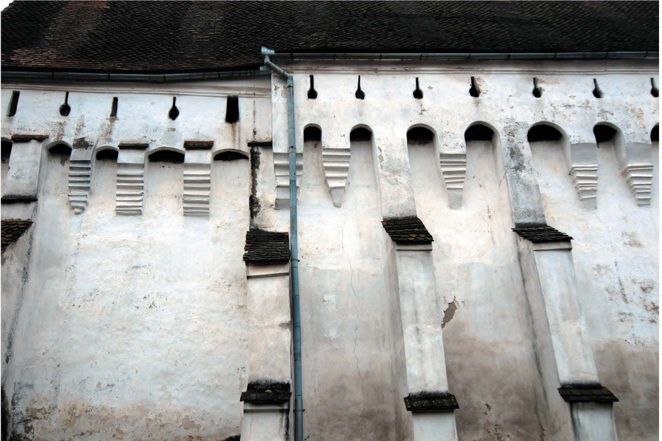
Détail de la fortification: meurtrières et mâchicoulis Fortification detail: the loopholes and the machicolations
