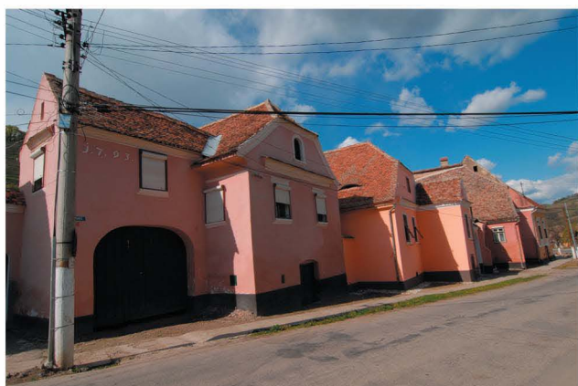
Front de la rue Aurel Vlaicu House fronts on Aurel Vlaicu street
