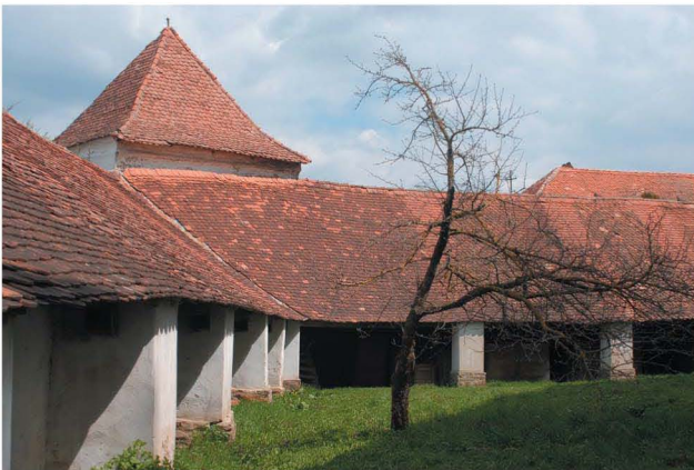
Le côté sud de l'enceinte fortifiée. Galerie pour les caissons à céréales Southern side of the fortified precinct, gallery with crates for grain
