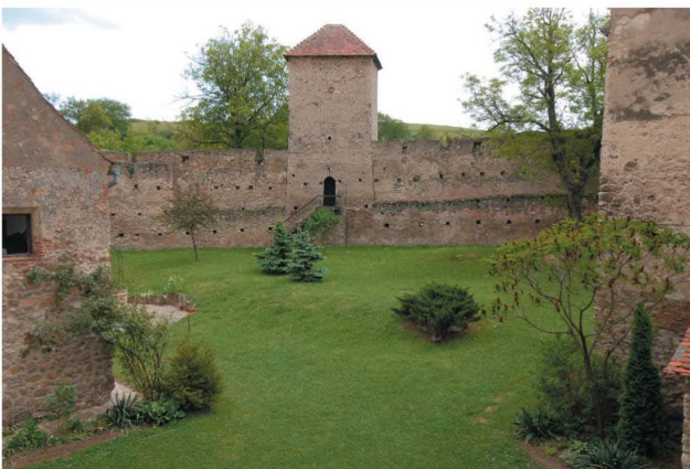
L'enceinte intérieure, avec la tour sud - est et les vestiges du chemin de ronde Inner precinct with the south - east tower and remains of the sentry road
