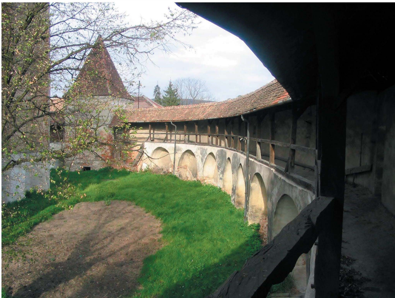
Le côté sud de l'enceinte fortifiée: le chemin de ronde Southern side of the fortified precinct: the wall passage
