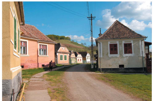
Front de façades dans le quartier roumain House fronts in the Romanian quarter
