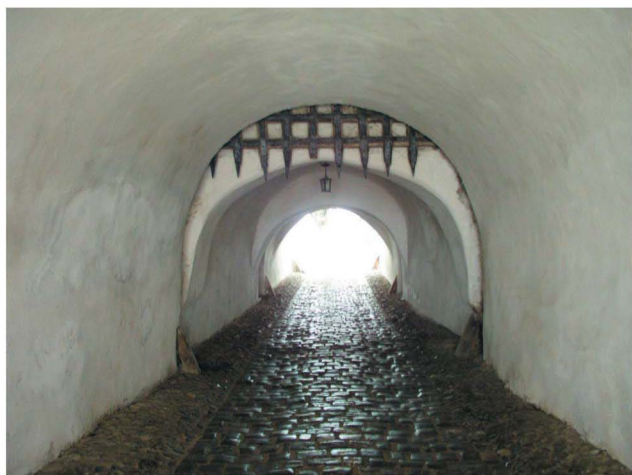
Couloir d'accès à herse situé sous la tour - porte Access way under the tower, with grating
