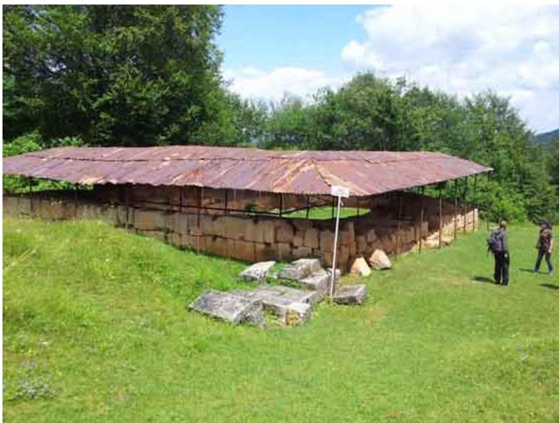
Sistem de protecție temporar existent din anii 80, in stare de colaps
